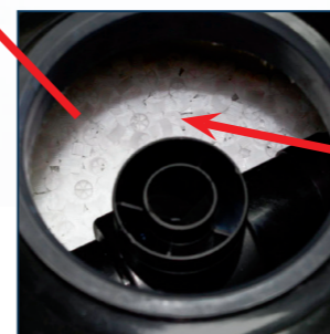
Внутренний объём фильтра заполнен биоэлементами 17x10 мм из нейтрального пластика с развитой поверхностью ок. 1000 м²/м³
